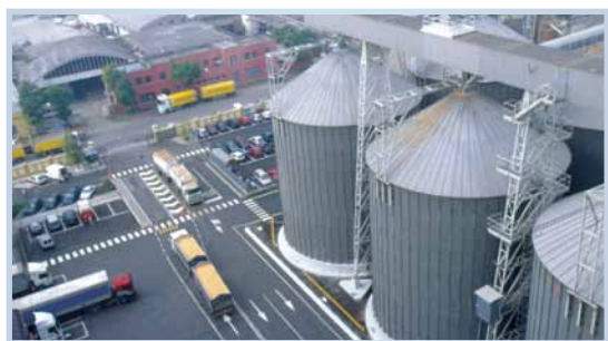
Stabilimento di Marghera (VE)
